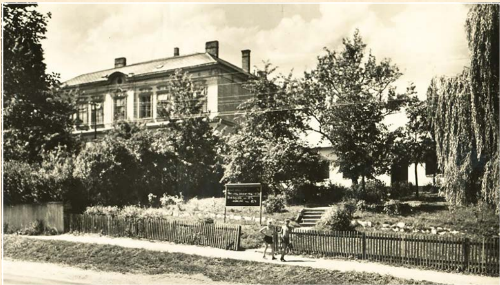
Pohled na svatoborskou školu, která byla vystavěna v roce 1906 a vpravo od ní je stará panská budova, později mateřská školka, objekt byl zbourán v r. 2020.
