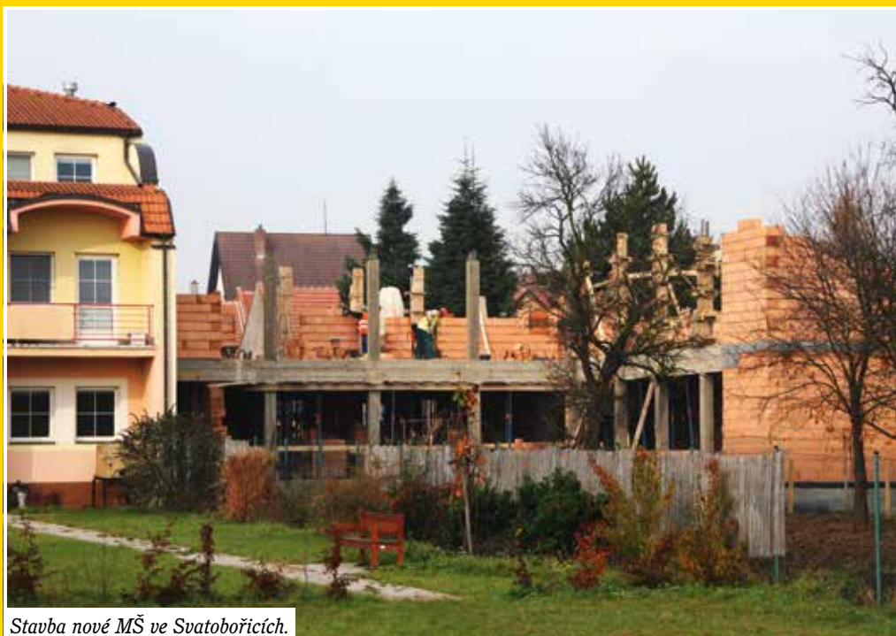
Stavba nové MŠ ve Svatobořicích.
