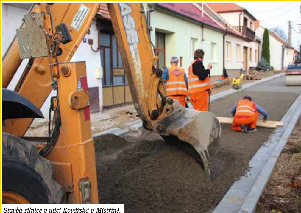
Stavba silnice v ulici Kovářská v Mistříně.
