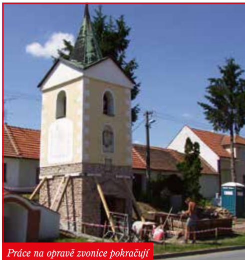
Práce na opravě zvonice pokračují
